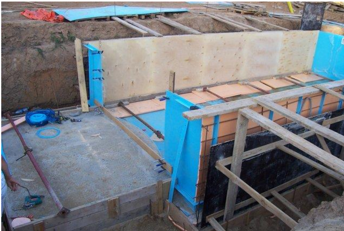
Установка внутренней опалубки
